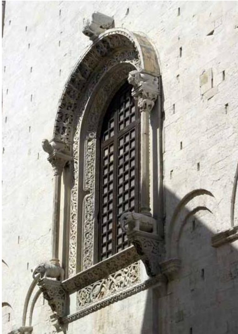
Bari, Kathedrale, Hinterfassade, Apsisfenster.
