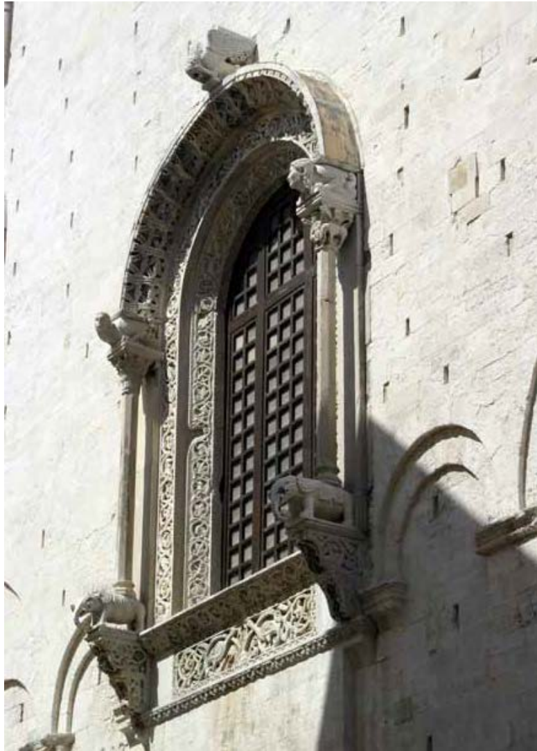
Bari, Catedral, fachada posterior, ventanal del ábside
