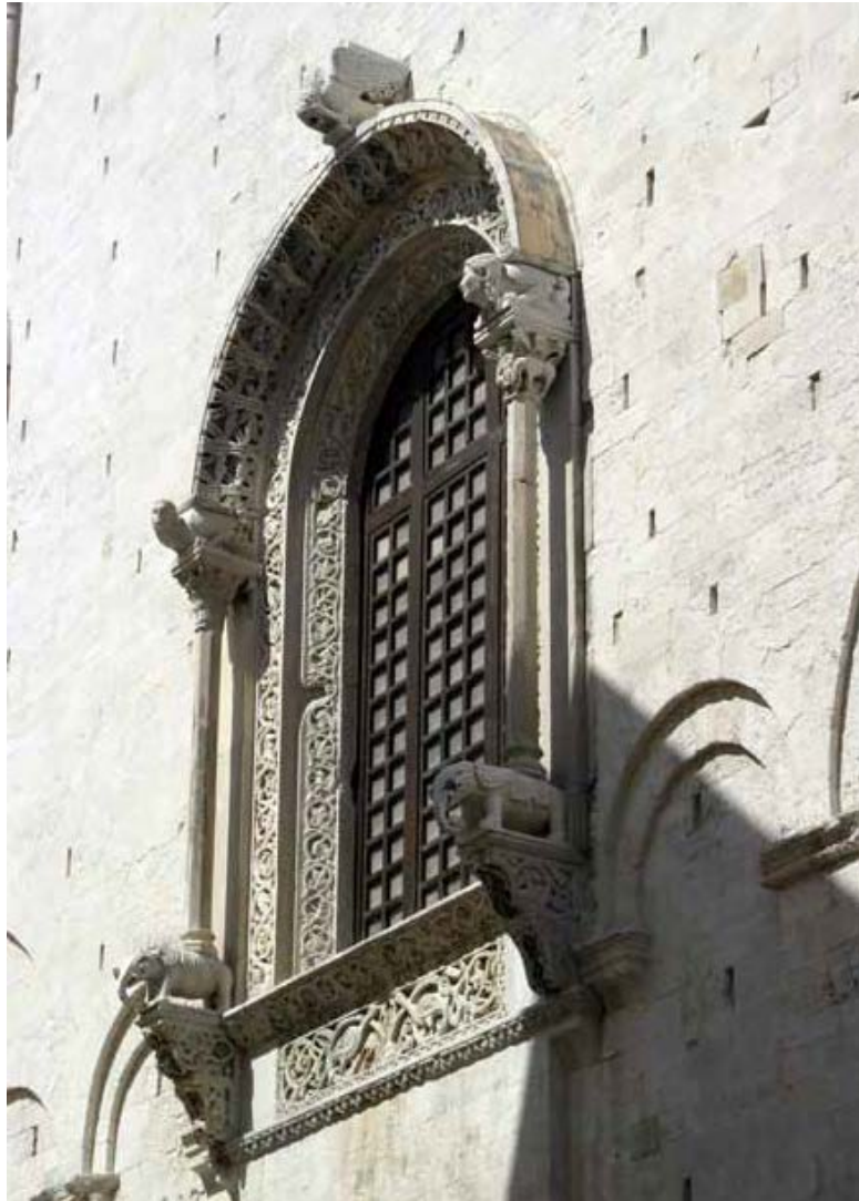
Bari, Kathedrale, Hinterfassade, Apsisfenster.
